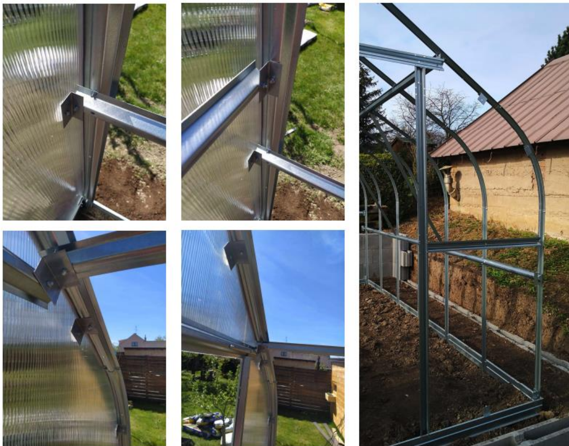
Obrázek 10.3 – pozice úhelníků
