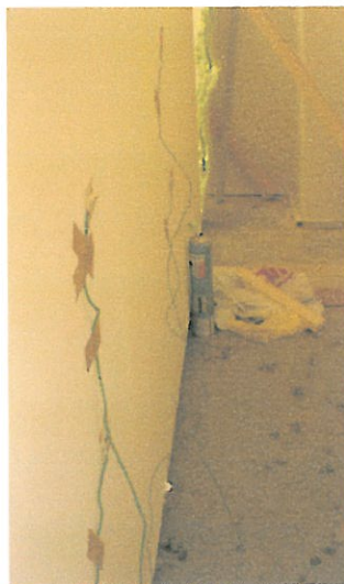
Foto 3. Pohled na umístění termočlánků na interiérové straně posuzovaného panelu
