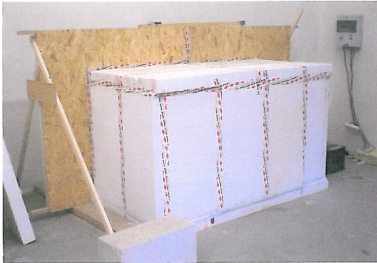
Foto 1. Pohled na posuzovaný vzorový panel předstěny
